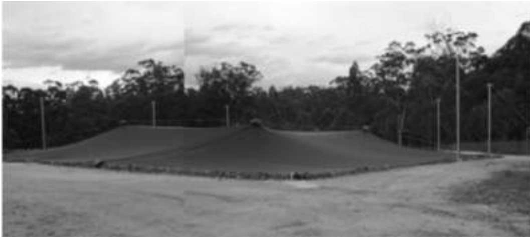
شکل ۱-۲. نمایی از سازه‌های سایه‌انداز
