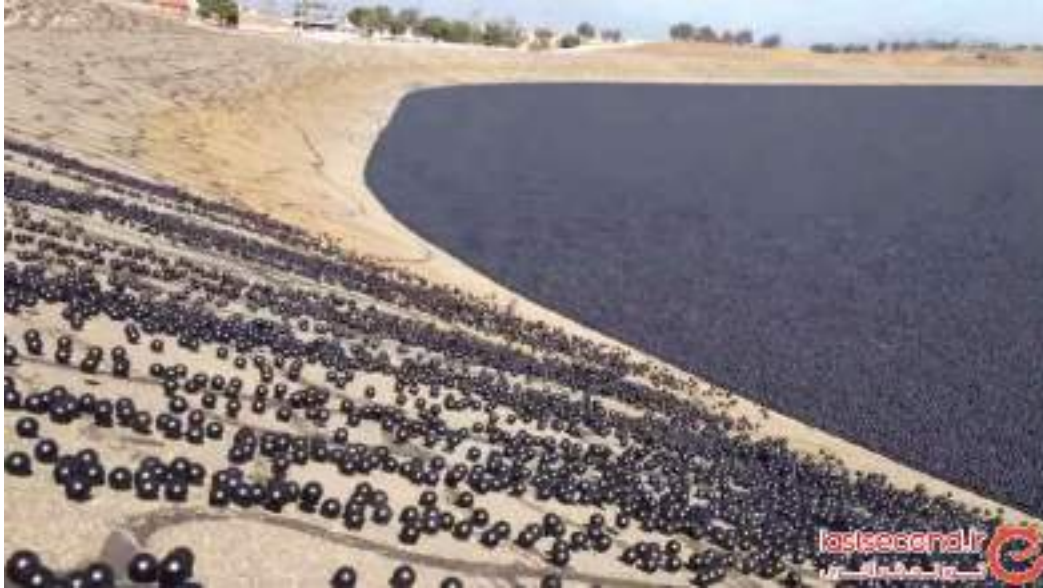
شکل ۶-۱. نمایی از رهاسازی توپ سایه جهت کاهش تبخیر در مخزن یک سد
